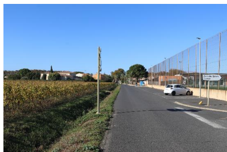
Situation actuelle (Source : EGIS)
